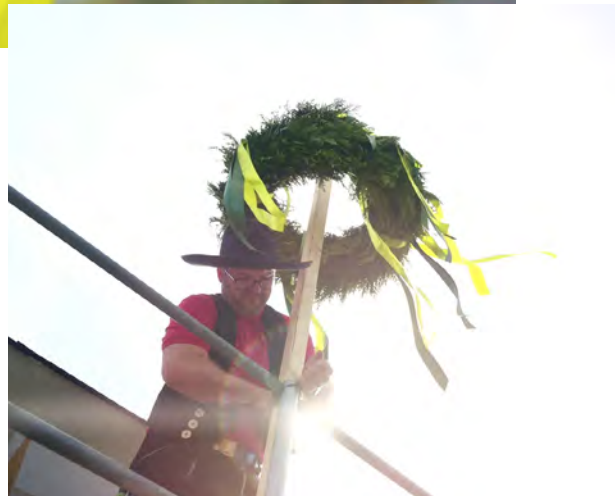
Hubert Brüggjenjürgen junior (Zimmerei Hubert Brüggjenjürgen GmbH) befestigt den Richtkranz und hält im Anschluss den traditionellen Richt- spruch.
