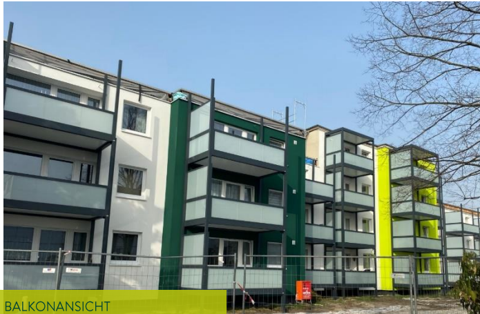
BALKONANSICHT BONHOEFFERSTRASSE 6, 8 UND 10
